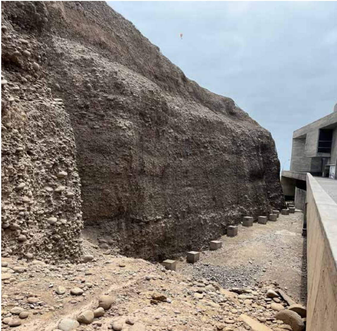
Fotografía N°4: Acantilado de la Costa Verde adyacente al LUM, el cual está en peligro de colapso ante la ocurrencia de un sismo.
