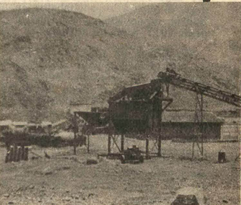
Terreno que usurpa ICCGSA en el P.J. "Mariátegui".
