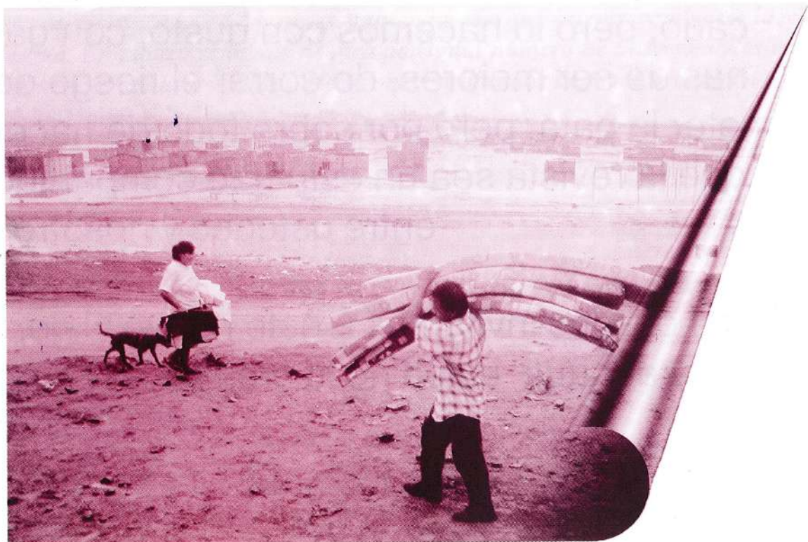
FOTO: TAFOS/Susana Pastor (Daños Panamericana Norte - Chiclayo)
