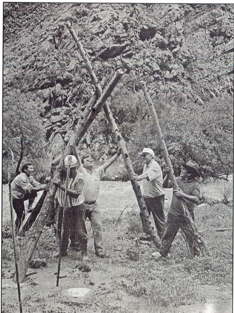
FOTO: CEDRUM/Churín (Reparación de postes de luz)
