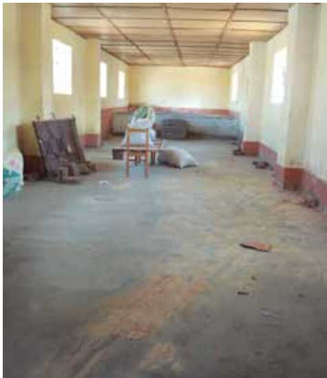
Local comunal con costales de abono en su interior. Distrito de Yanacancha. Año 2011.
