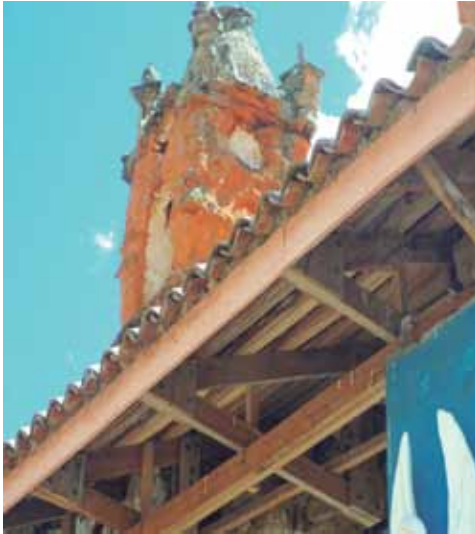
Conservación de vigas de parte frontal del cementerio, distrito de Ulcumayo. Año 2011
