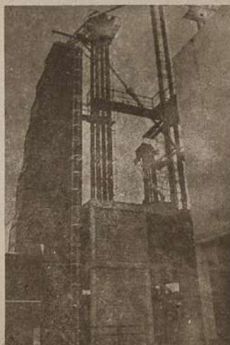
Vista parcial de las instalaciones para el precoccido del arroz pertenecientes al Complejo Agroindustrial del Tolima "CATSA".
