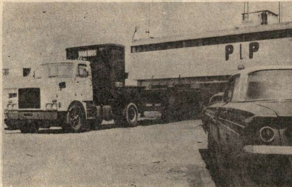
Camión cargado con las planchas sustraídas en la PIP de Chimbote.
